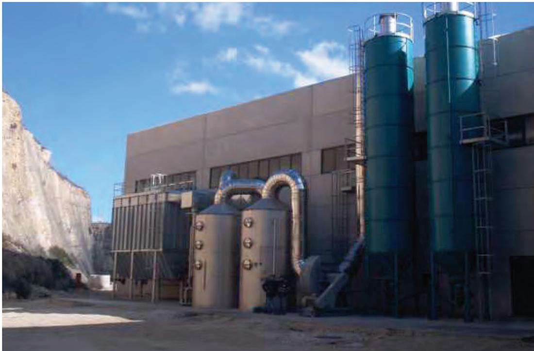
**Figura 26 - Trattamento aeriformi impianto inertizzazione rifiuti**
