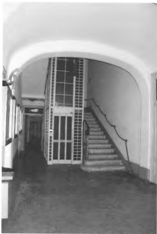
Figura 17: Vano scala e ascensore
