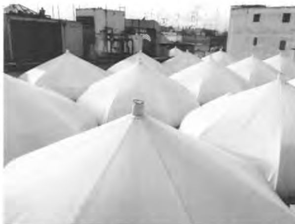
Figura 14: Copertura con struttura portante in acciaio
