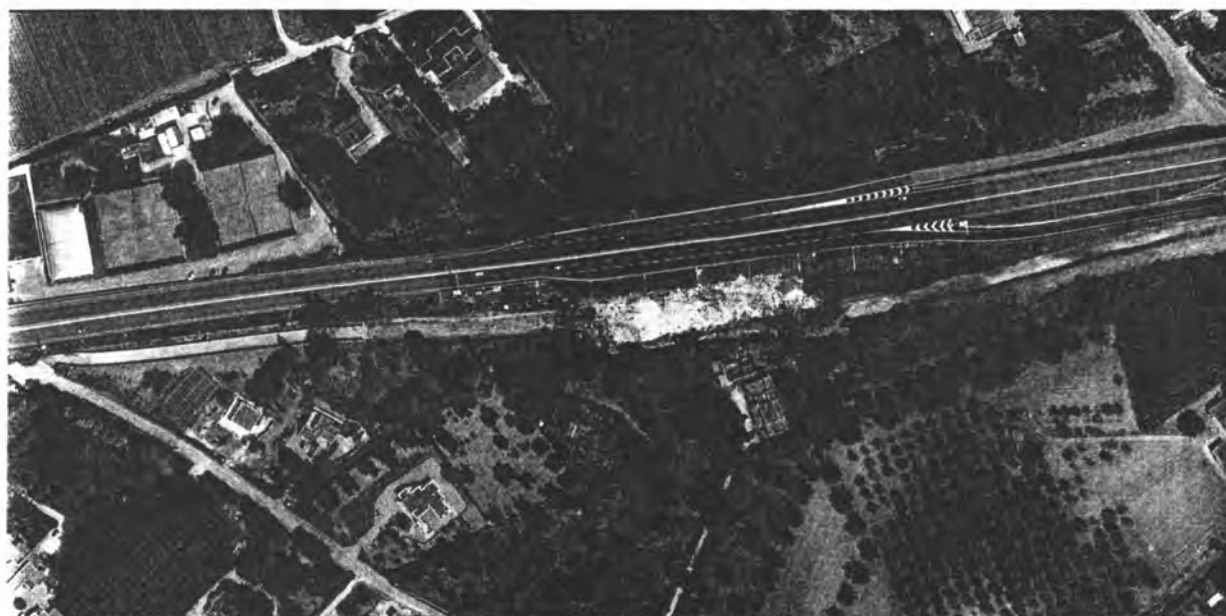
Il "Fosso Canale" nel tratto obliterato dalla costruzione della Strada Statale 7.
