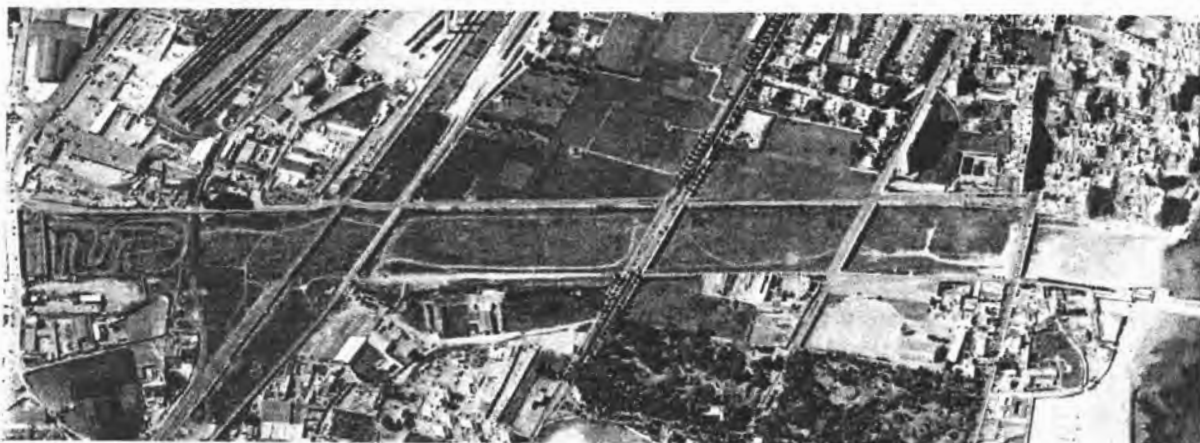
Il canale deviatore della "Lama Lamasinata", Bari.
