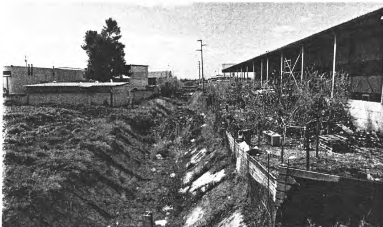
Il "Canale Ponticello" nei pressi della zona industriale, Ortanova.
