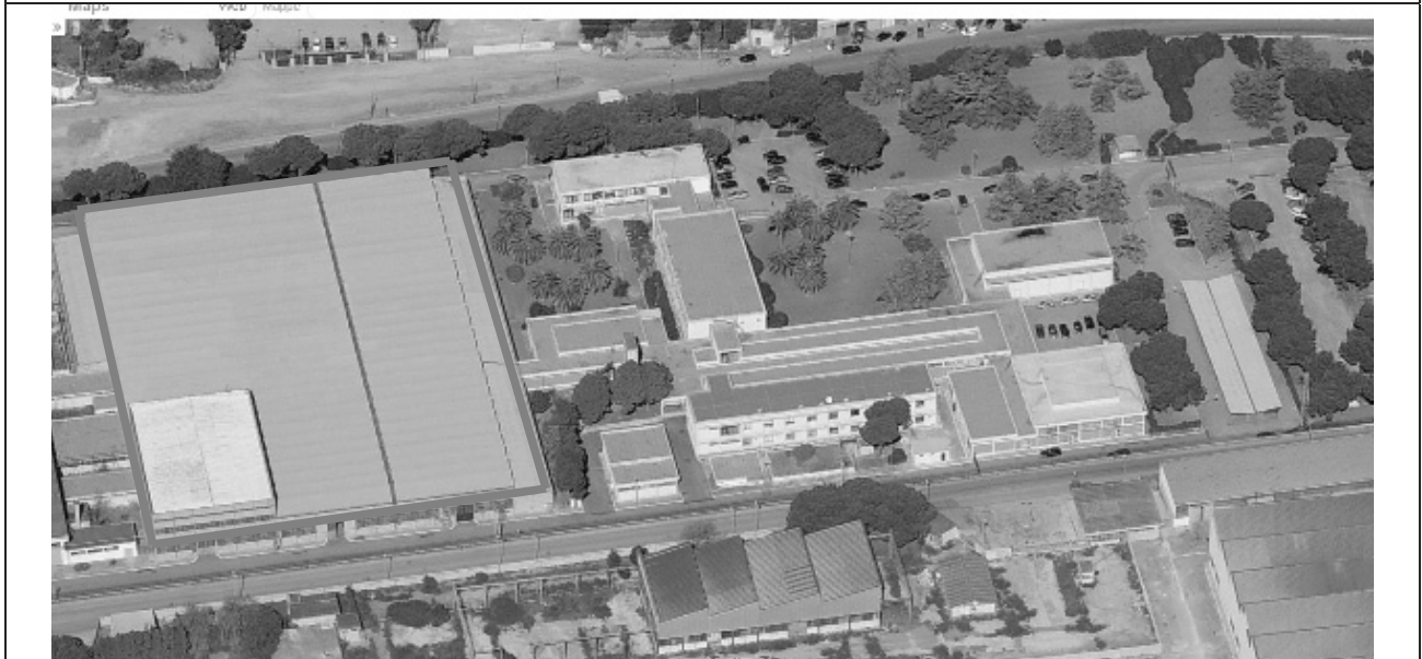
Foto aerea del capannone da adibire ad archivio
