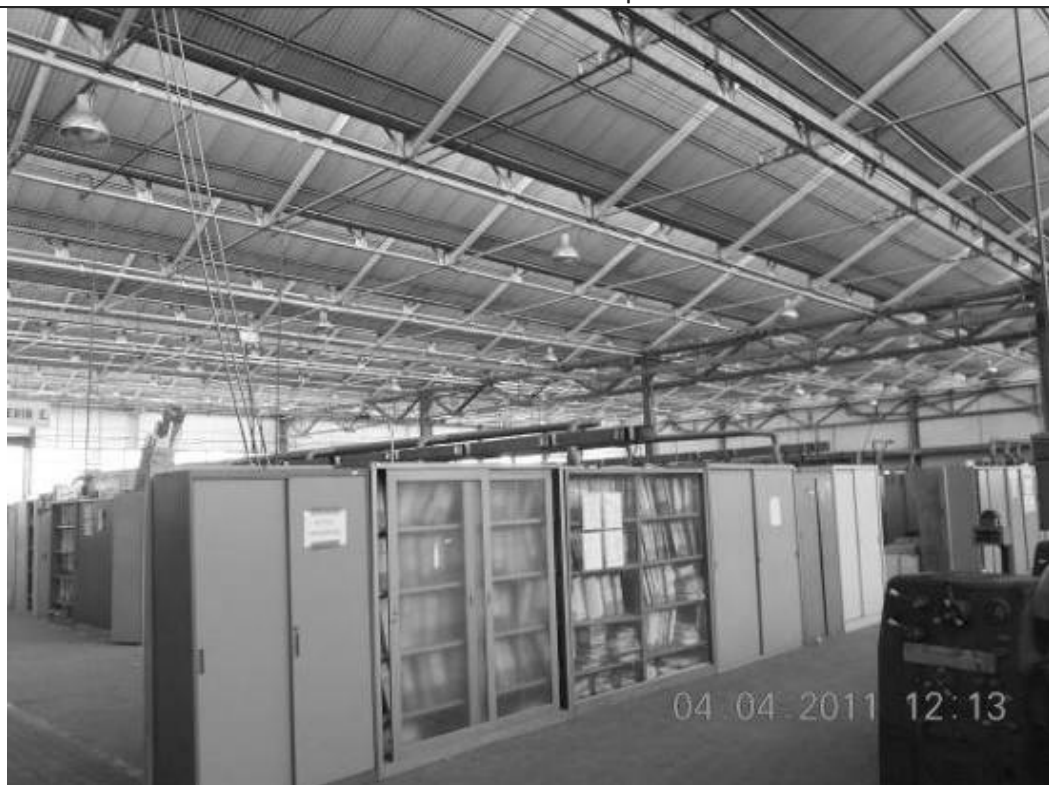
Foto stato attuale
