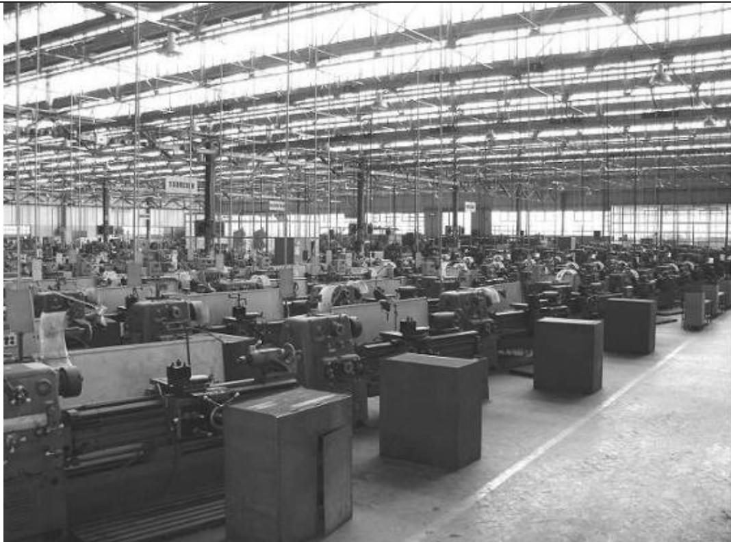
Foto stato attuale del capannone
