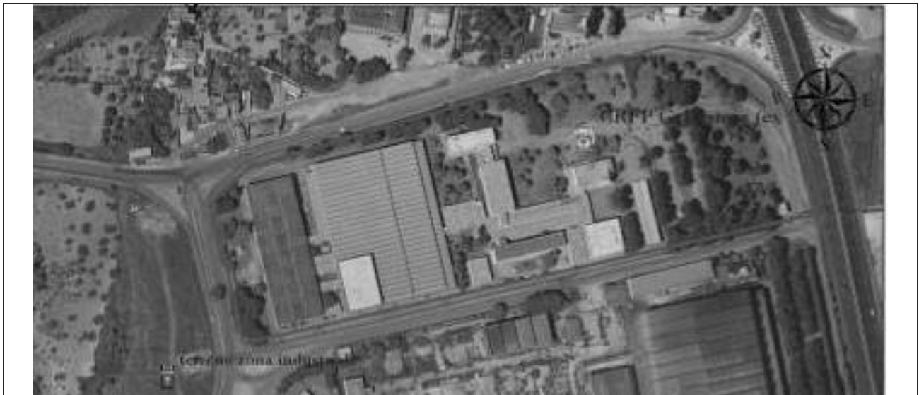
Ortofoto della struttura ex CIAPI
