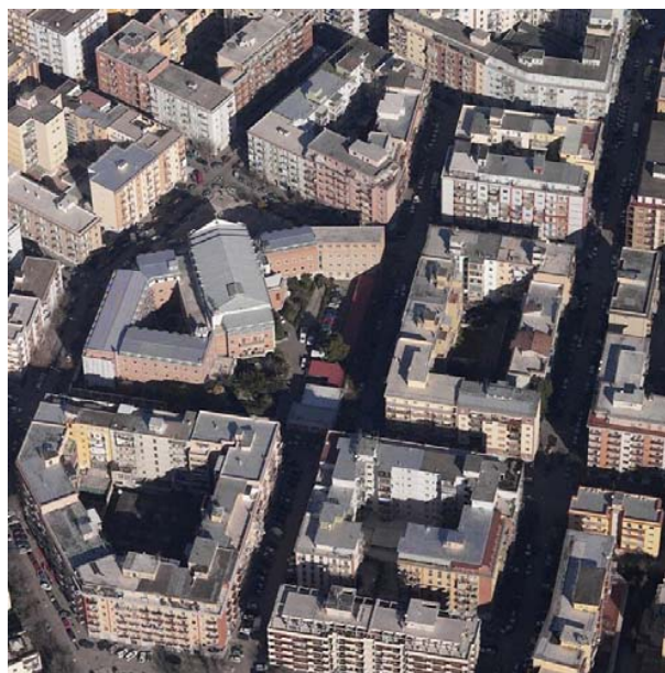
Foggia: isolati a cortina chiusa ortogonali con affaccio interno , foto aerea
