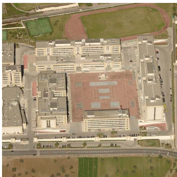
Bari: "cittadella" isole racchiuse con recinti controllati , foto aerea
