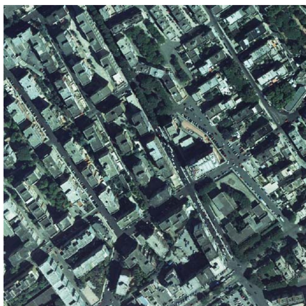
Brindisi: gli isolati longitudinali "a stecche" , ortofoto
