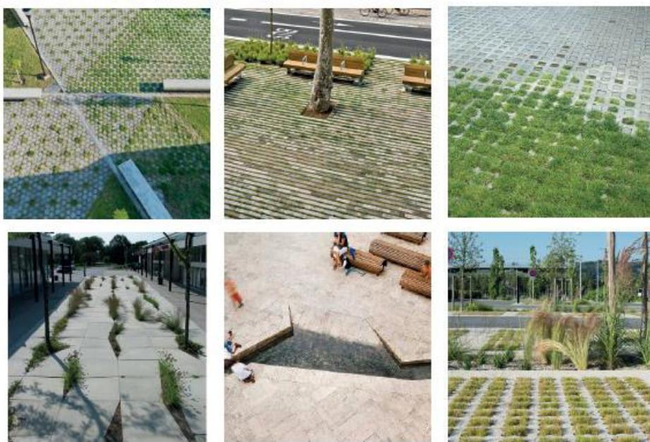
Figura 25. Esempi di pavimentazioni urbane permeabili.
