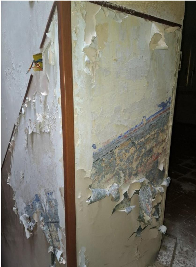
*Figura 14. Dettaglio degrado superfici interne*
