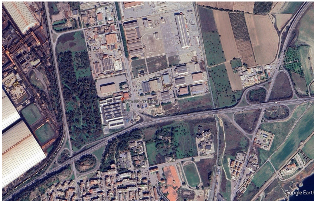
Figura 10.1. Vista satellitare dell'impianto IRIGOM RV (fonte: Google Earth)
