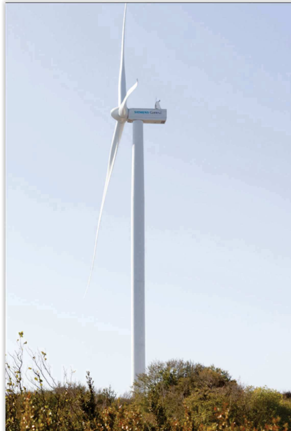
Fig. 2 – Immagine di un aerogeneratore SG 4.5 -155 già montato.
