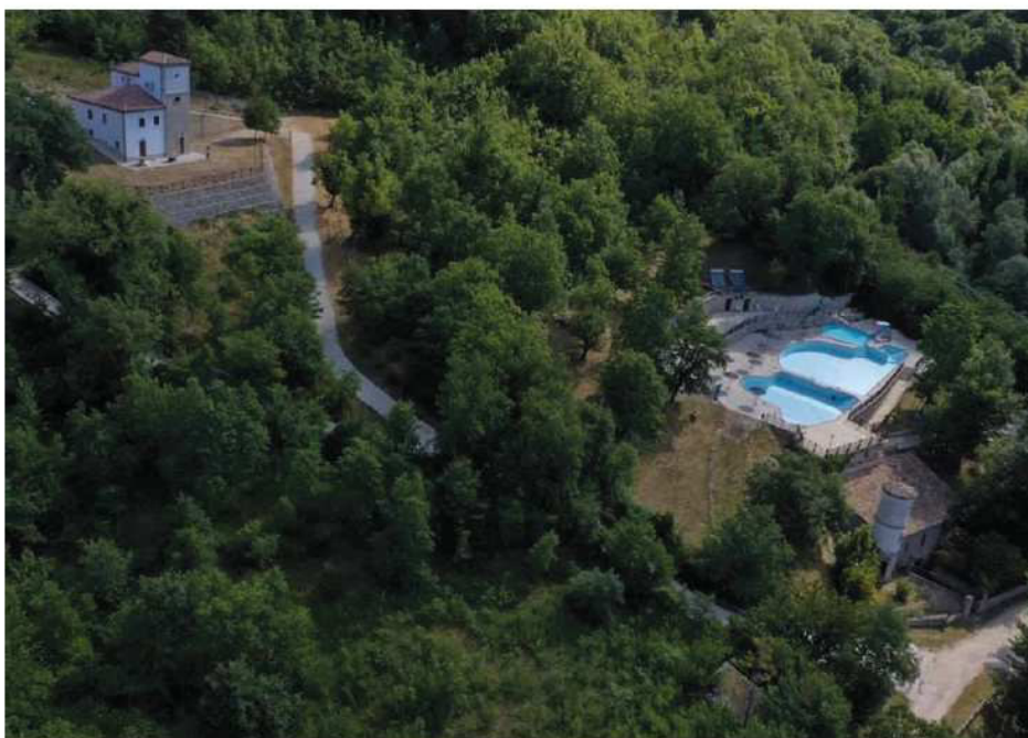
Fig.3 Area dei mulini ad acqua – Locanda del Mugnaio, piscine e Mulino vecchio a monte
