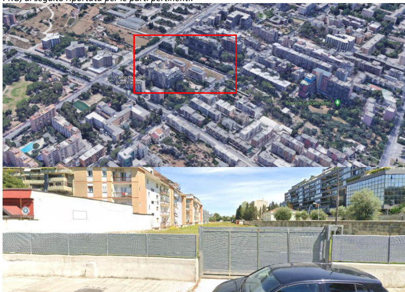
Fig.4 Vista area d'intervento
