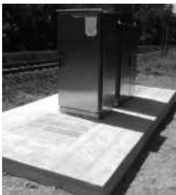
(Fig. 5: tipologico armadietto, rif. elaborato "148. OC00 - Relazione tecnico-descrittiva delle opere civili Parte 2 (Shelter leC e Armadi di linea)")
