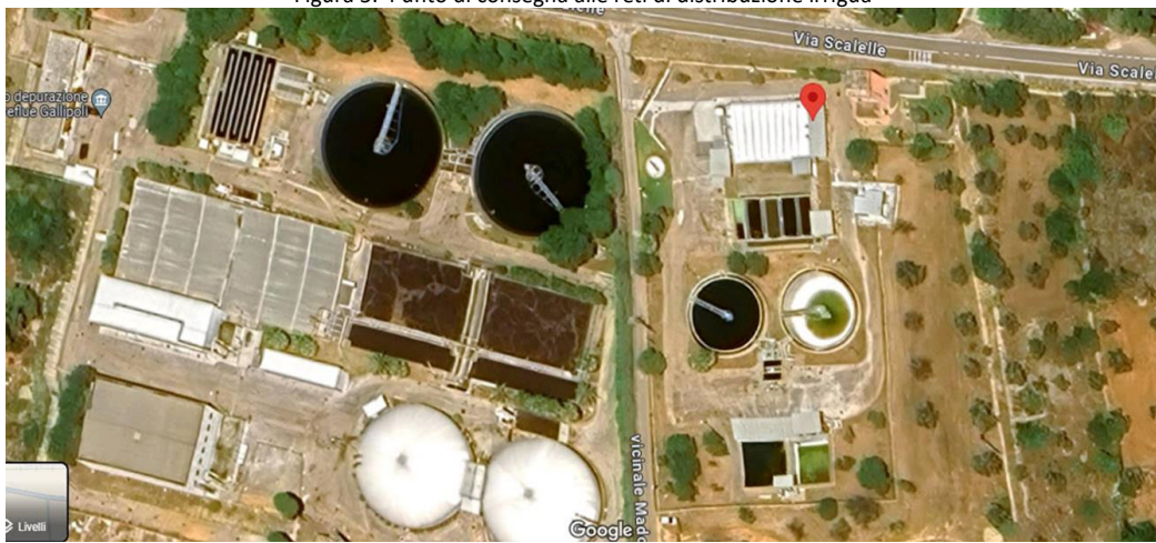
Figura 5: Punto di consegna alle reti di distribuzione irrigua
