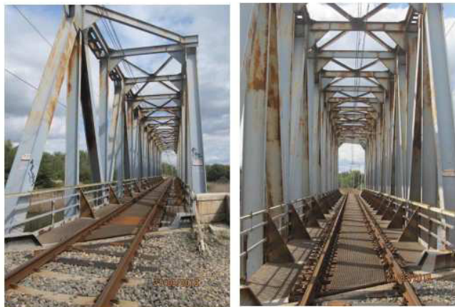
Figura 2.3 – Stato di fatto travata metallica al km 22+737 della linea Taranto-Sibari
