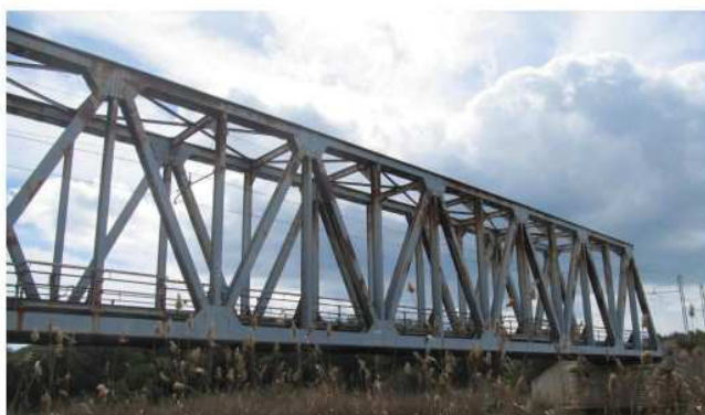
Figura 2.2 – Stato di fatto travata metallica al km 22+737 della linea Taranto-Sibari
