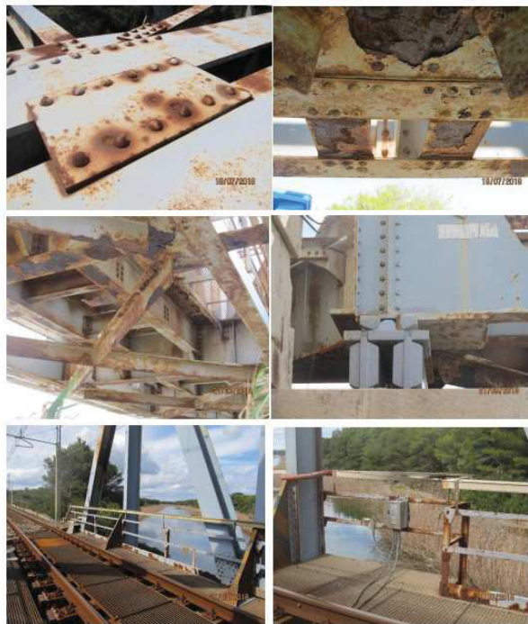
Fig. 8 – Stato di fatto e particolari della travata metallica
