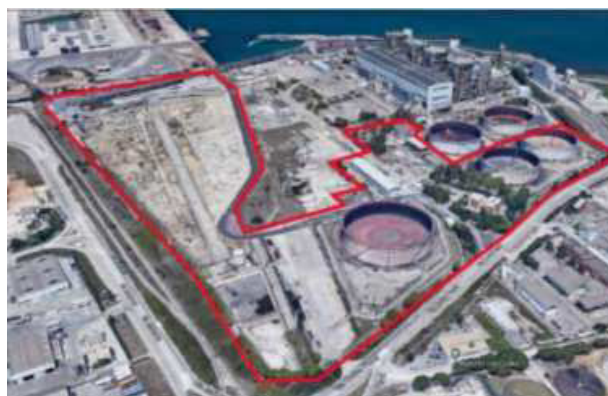
Fig. 2. Stato dei luoghi
