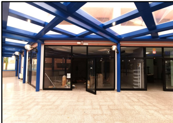
Locale bar - accesso da porticato interno
