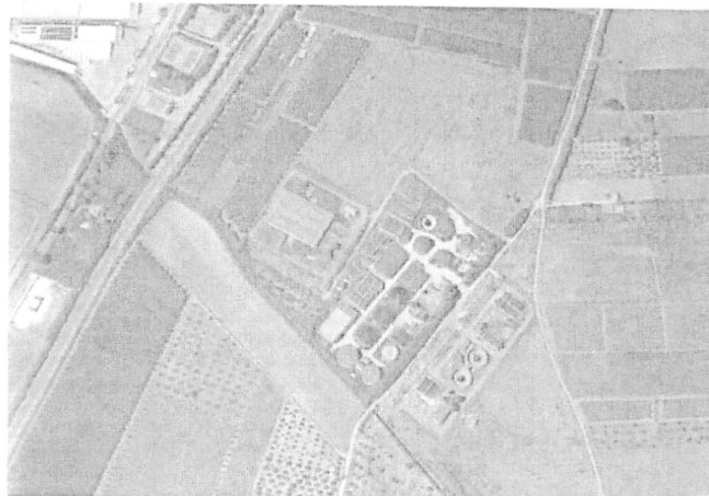
L'impianto dall'alto (fonte Google maps)
