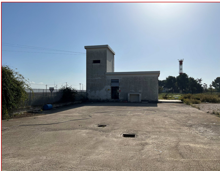
Figura 13 - Locali Centrale Elettrica
