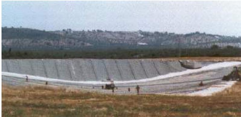
*Figura 50: Operazioni di posa del telo impermeabile per la realizzazione di uno dei due laghetti collinari*
