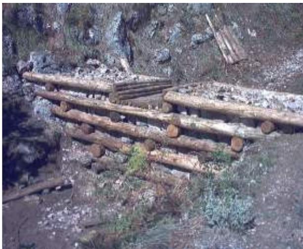
*Figura 45: Esempio di briglia in legname e pietrame realizzata dal Consorzio di Bonifica Montana del Gargano*
