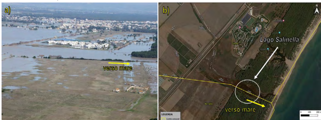
Figura 50 – Evento alluvionale del 7 ottobre 2013: a) Situazione post alluvione a monte del Lago Salinella, a circa 2 km a sud-ovest del centro abitato di Marina di Ginosa. Le acque di invaso del lago sono esondate e hanno trovato sfogo verso il mare. b) In condizioni normali non vi è collegamento idraulico superficiale tra il Lago Salinella e il mare.
