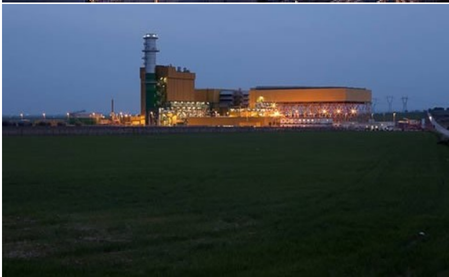
Immagini della centrale dal sito del Comune di San Severo 5 e dell'impresa MA.DE. 6
