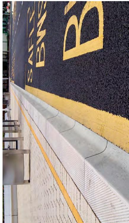
Figura 191. Specifiche tecniche dei sistemi BRT – Ottimizzazione dell'accosto alla fermata.
