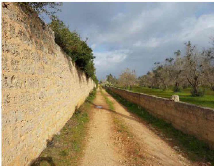
Figura 189 – Area naturale Bosco Macchia di Ponente – Ripreso da terra – A sinistra il muro perimetrale che protegge il bosco
