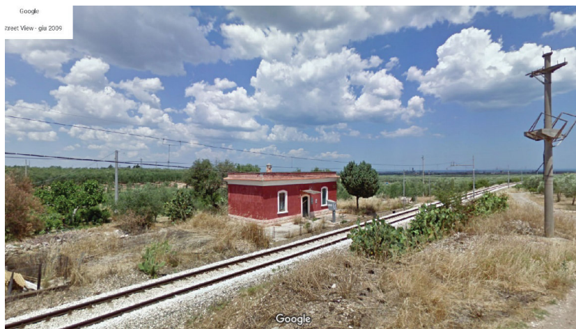
La casa cantoniera n. 22 destinata alla demolizione
