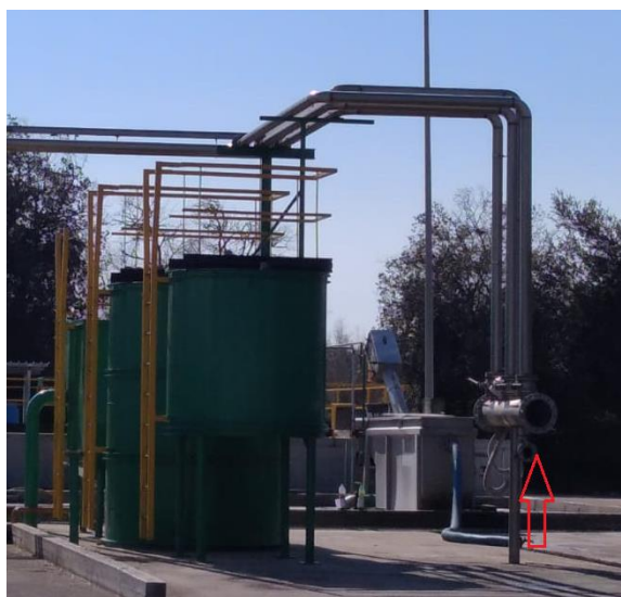
Figura 9 – Punto di scarico esistente dove collegare lo sgrigliatore
