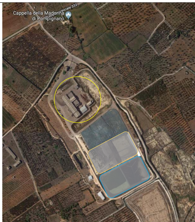
Figura 1- Impianto Complesso LE3 con annessa discarica
