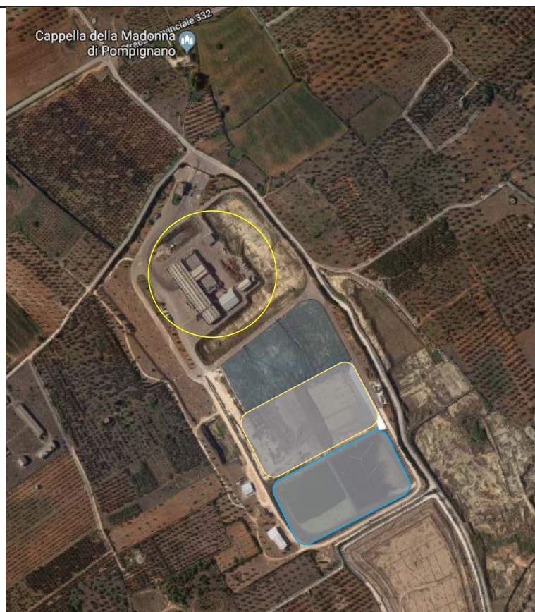
Figura 1- Impianto Complesso LE3 con annessa discarica
