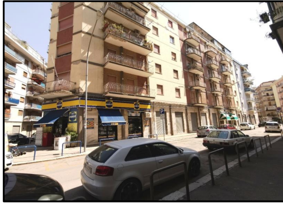
Prospetto esterno via Taranto
