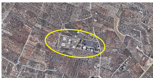
Impianto di depurazione consortile Ruvo/Terlizzi con adiacente impianto di affinamento
