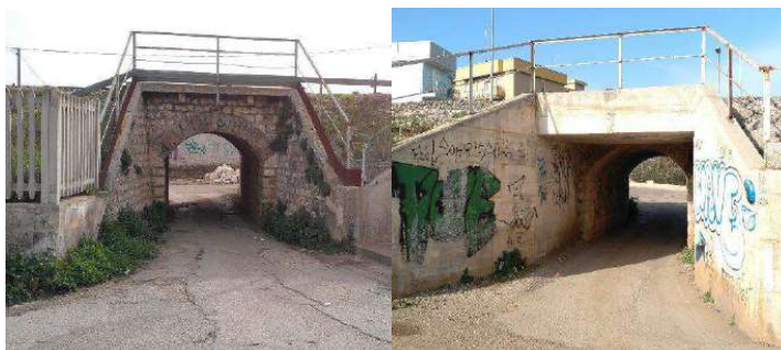
Fig. 2 _ Sottovia al Km 24+323 (stato attuale)
