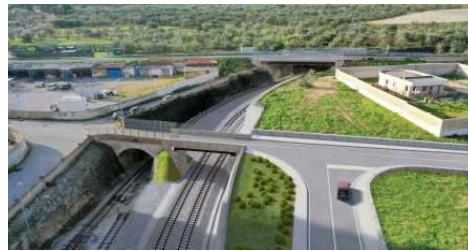
Fig. 4 _ Nuovo sovrappasso al km 21+908
