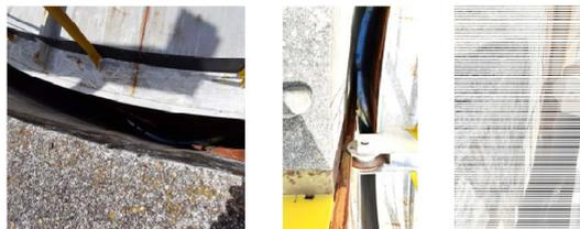
*Stato di conservazione della carpenteria metallica con evidenti segni di degrado da corrosione*
