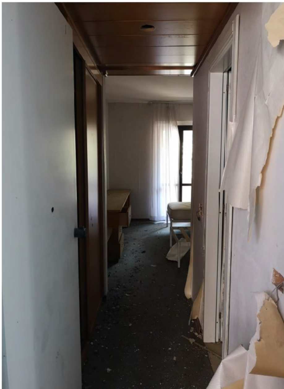
Vista dall'ingresso di una camera
