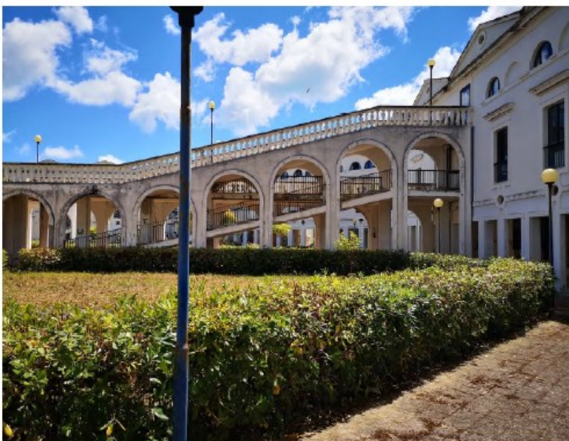
Sistemazione della corte interna con dettagli costruttivi ed impianti obsoleti
