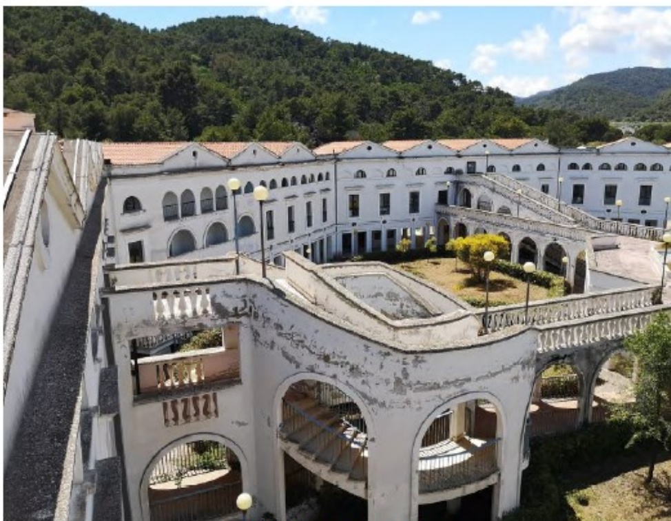
Vista dall'alto della corte interna
