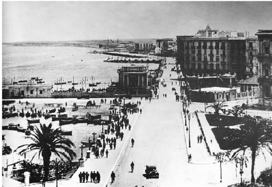
Il contesto di intervento in una foto degli anni '20-'30
