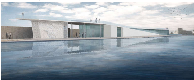
Vista del Molo Sant'Antonio e del Muro
