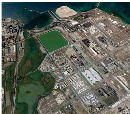
Figura 6.9: Area industriale della Basell
