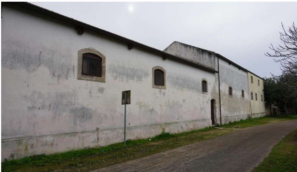
f.23_Prospetto esterno ex stalle e blocco d'angolo ricostruito.
