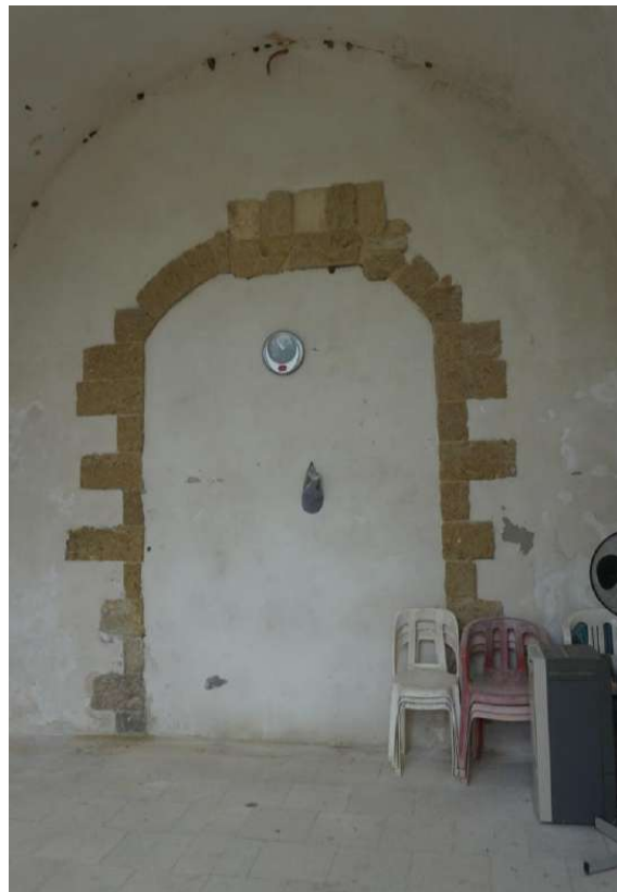
f.17_Ambiente interno della Torre al piano terra – dettaglio del portale d'ingresso originario tamponato in seguito alla giustapposizione del contrafforte presente in facciata.
