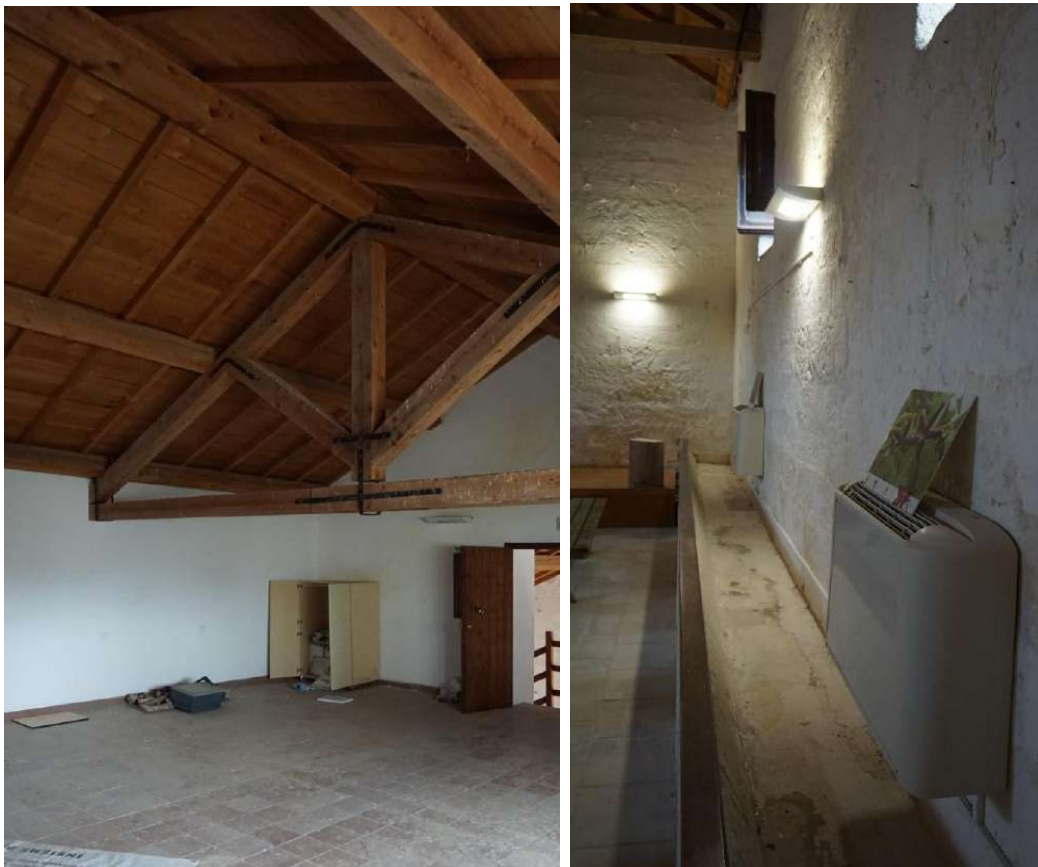
f.10_Vista interna della stalla del piano primo dell'ala sinistra – capriata lignea ricostruita durante i lavori di restauro degli anni 2010.
