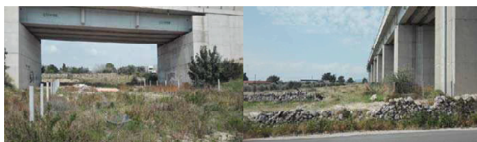
Sottopasso Ferrovia Tratto a Sud del viadotto ferroviario con attraversamento stradale (cfr. paragrafo 2 – pagg. 2-3-4-5).
