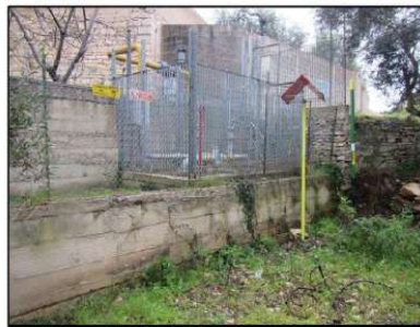
FOTO 1 - VISTA STATO ATTUALE
