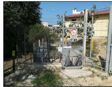
FOTO 2 - VISTA STATO ATTUALE
