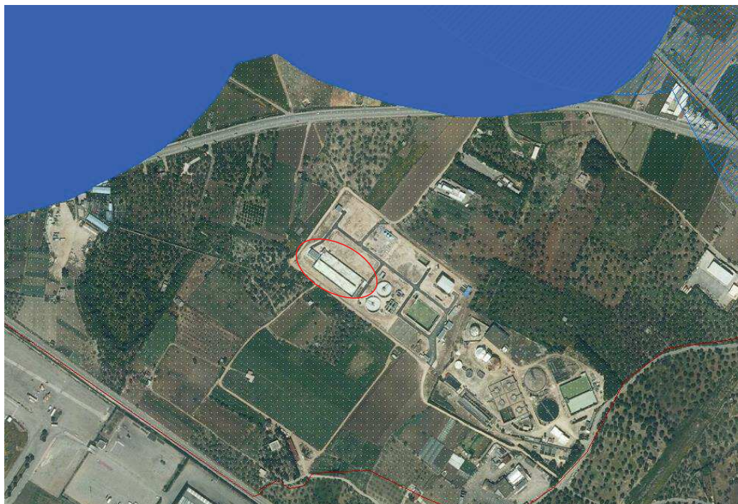
Inquadramento area di intervento nell'impianto di affinamento di Molfetta (in rosso) su cartografia del PPTR - tutti i tematismi accesi
