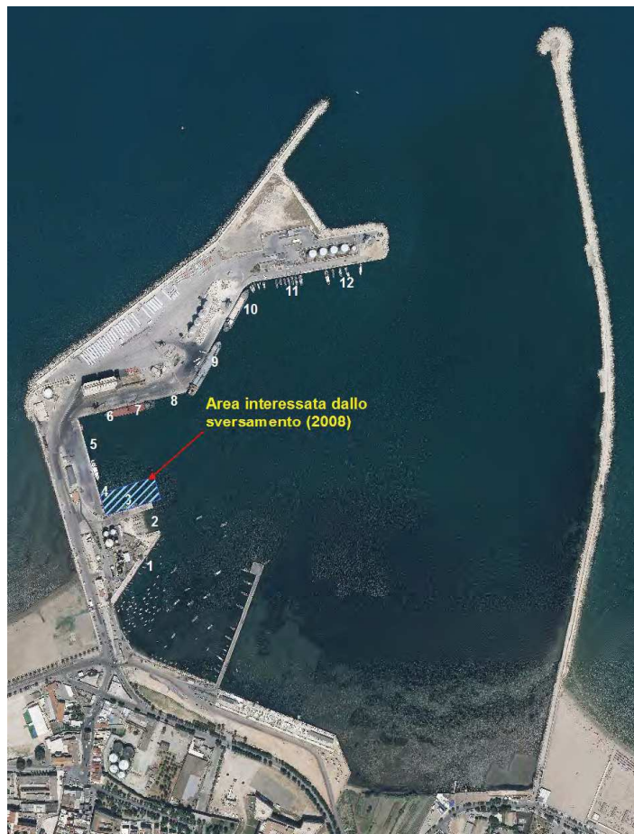
Figura 1.2.3 – Ubicazione area interessata dallo sversamento di olii combustibili nel 2008
