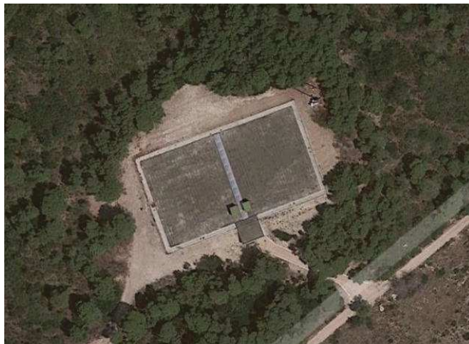
Serbatoio dell’Eremita – 8.000 mc
