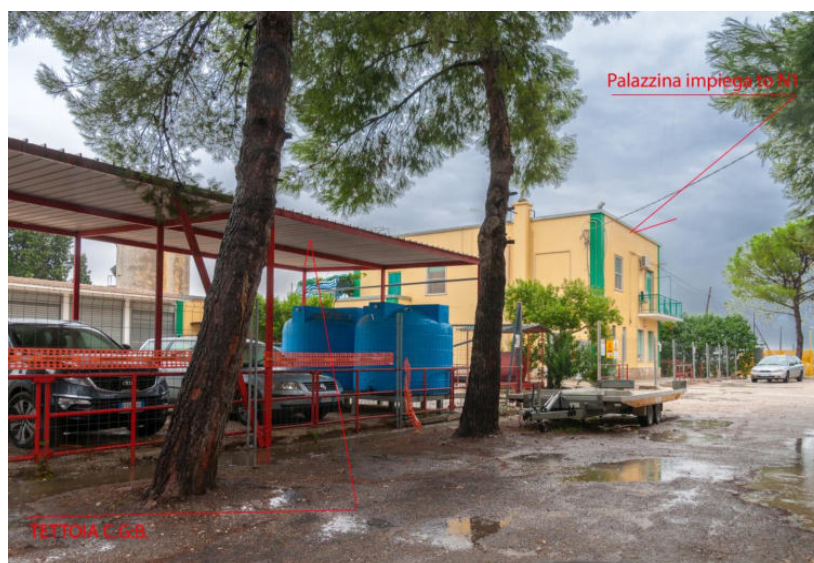
Figura 9. Foto n. 2 "ex palazzina impiegato".
