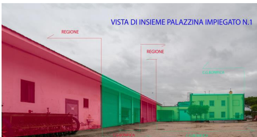
Figura 8. Foto n. 1 "ex palazzina impiegato".
