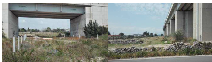
Sottopasso Ferrovia Tratto a Sud del viadotto ferroviario con attraversamento stradale (cfr. par. 2 – pagg. 2-3-4-5).
