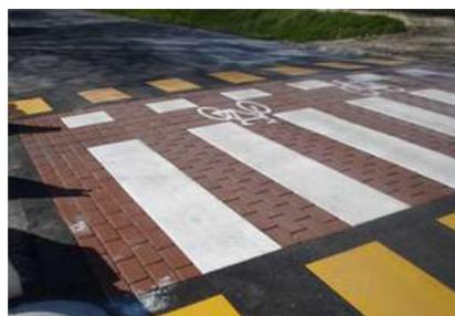
Figura 55 - Esempio di trattamento di irruvidimento superficiale e di attraversamento in asfalto stampato
