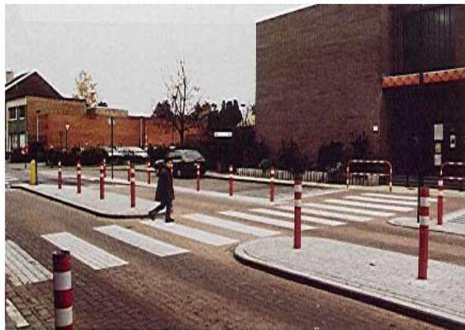
Fig. A1.3.2-Esempio di Attraversamento pedonale con isola salvagente IBSR, 1997.
