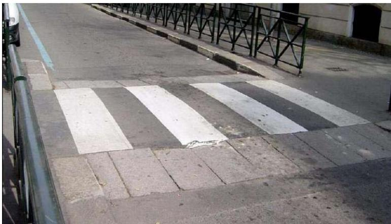
Figura 4: esempio di attraversamento pedonale rialzato con restringimento della carreggiata [4]
