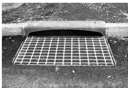
Figura 54 - Esempio di canalina per ciclisti e di caditoia in favore della mobilità ciclistica
