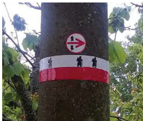
Installazione della striscia su palo in cemento (deve essere fissata su se stessa)
