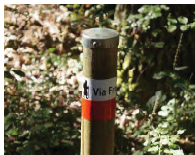
Quando non sono disponibili supporti bisogna installare paletti in legno su cui vengono installate le fascette.
