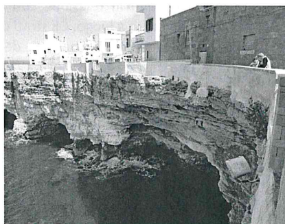
Grotta Pietropaolo – Vista da Ovest
