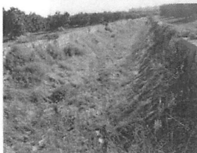
Stato di fatto dell'ultimo tratto da sistemare (sez. 41 - sez. 64)
