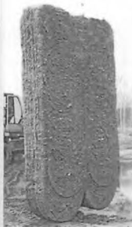
Diaframma di terreno dopo trattamento CSM
