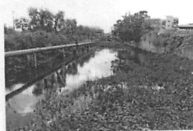
Sbocco del canale lato valle
