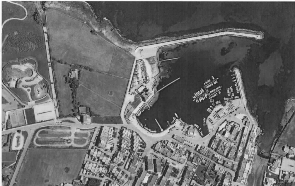
foto aerea stato dei luoghi Inquadramento territoriale
